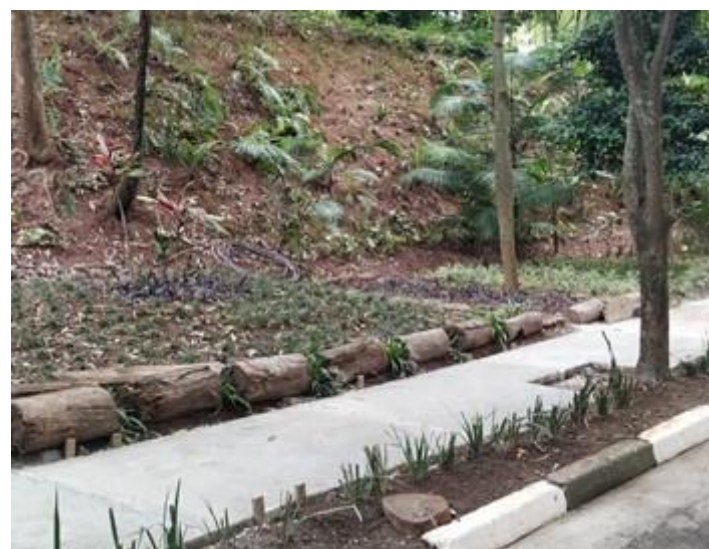
Figura 32. Calçada da rua principal depois da reforma
