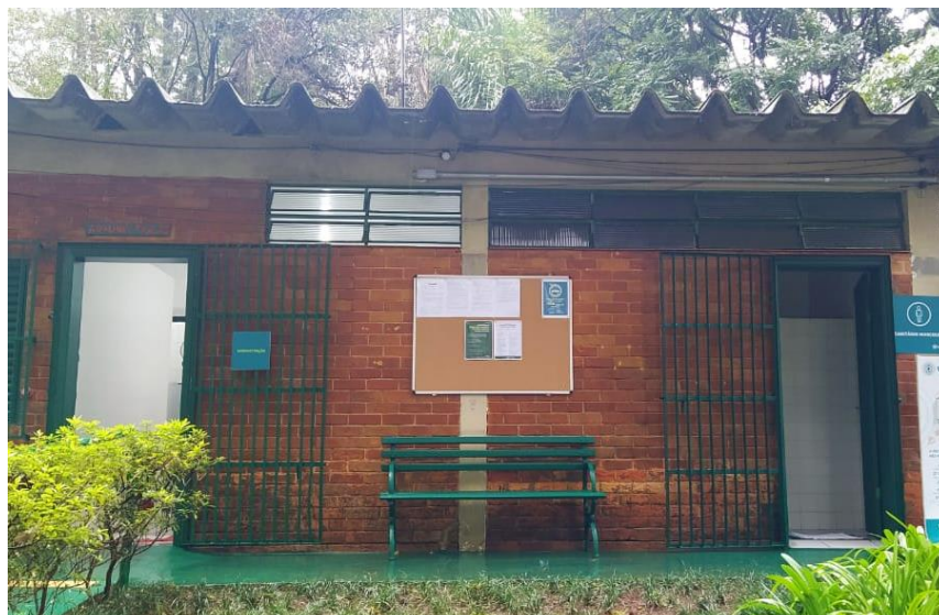
Figura 4: Instalação de painel com informativos do parque
