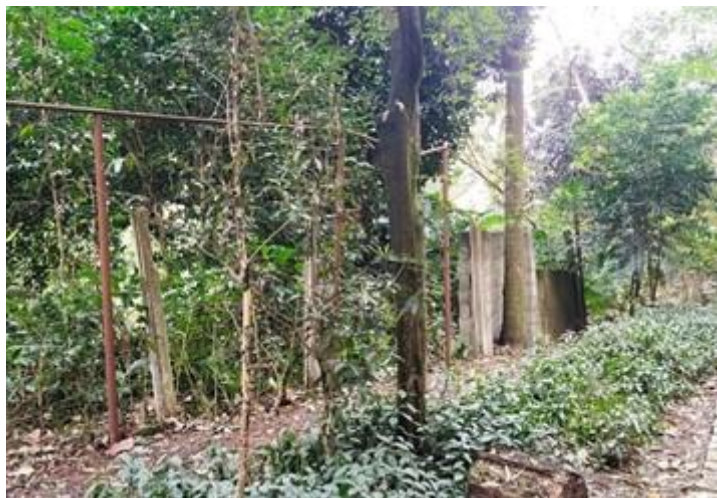
Figura 26. Muro antes da reforma
