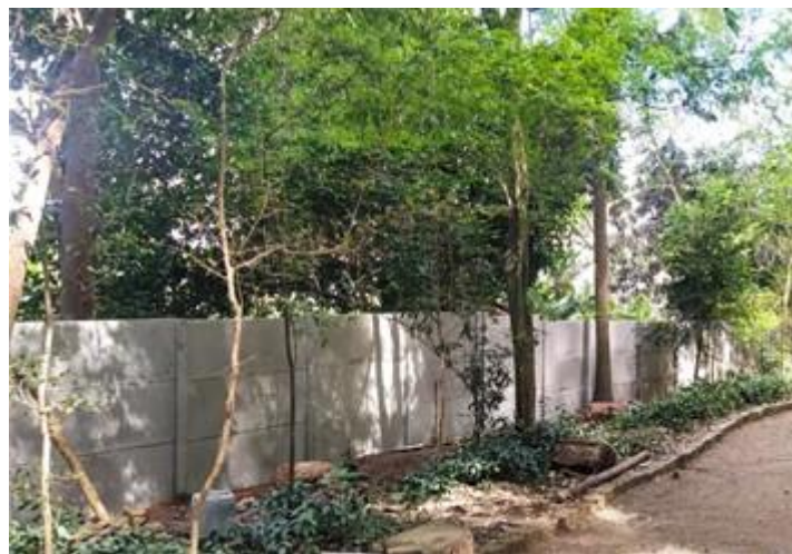
Figura 27. Muro após reforma
