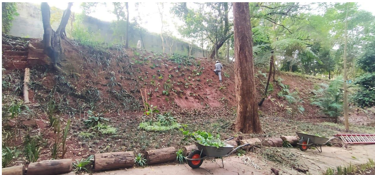
Figura 10. Plantio de forração no talude
