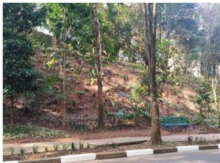
Figura 31. Calçada da rua principal antes da reforma
