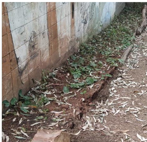
Figura 11. Canteiro antes da reforma
