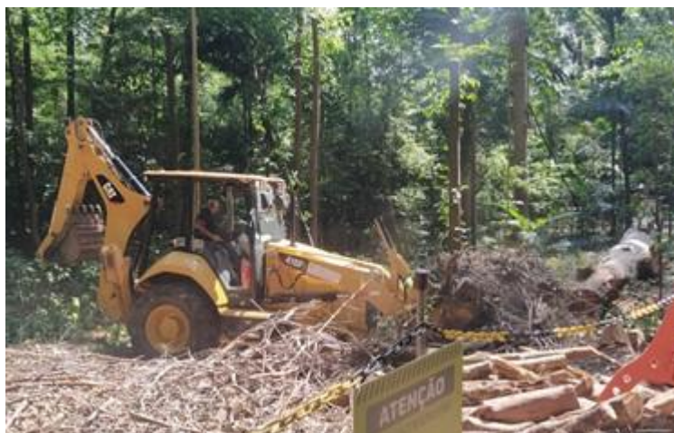
Figura 24. Remoção dos resíduos
